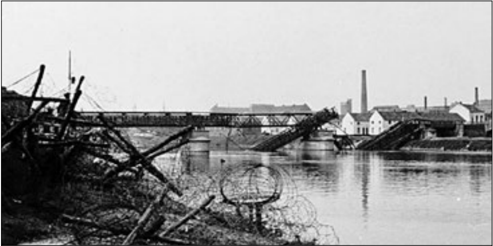
Abb. 13: Von den Niederländern am 11. Mai 1940 auf dem Rückzug gesprengte Eisenbahnbrücke über die Maas in Maastricht. Quelle: Bundesarchiv Bild 146-1984-093-24, unbekannter Fotograf/Wikimedia Commons.
